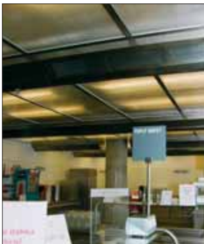
Polykarbonátový podhled větracího stropu ve výdeji byl na přání architekta změněn na dvouvrstvý a byl tím vytvořen zajímavý světelný efekt.
